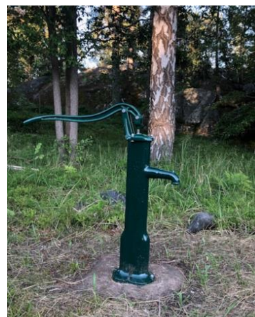
Handpumpen mellan S 39-41 har nyligen renoverats
